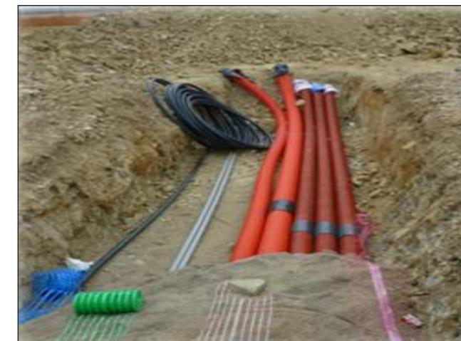
*Photo 11 : Câblage sur site entre les postes électriques (Source : IEL)*
