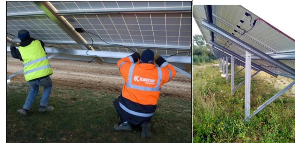
Photo 4 : Câblage des panneaux photovoltaïques
