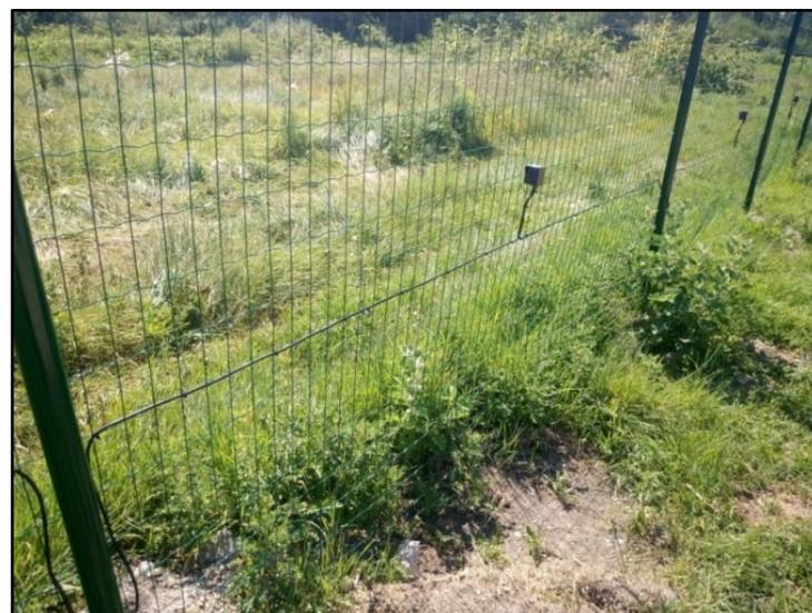
*Photo 10 : Système de vidéo-surveillance avec détection infrarouge (à gauche) et du câble de détection (à droite) – photos prises sur les centrales solaires d'IEL à Machecoul (44) et à Descartes (37)*
