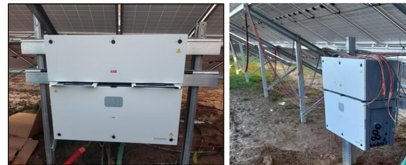
Photo 7 : Onduleurs fixés sur les structures photovoltaïques (Ferme Solaire de Beauvoir, photos prises en phase construction, IEL)
