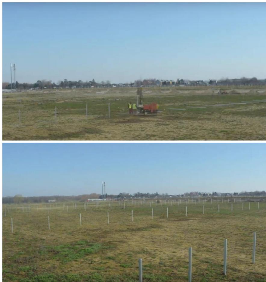
Photo 6 : Mise en place des pieux battus - photos de la construction de la Ferme Solaire Marc Energies, une réalisation IEL
